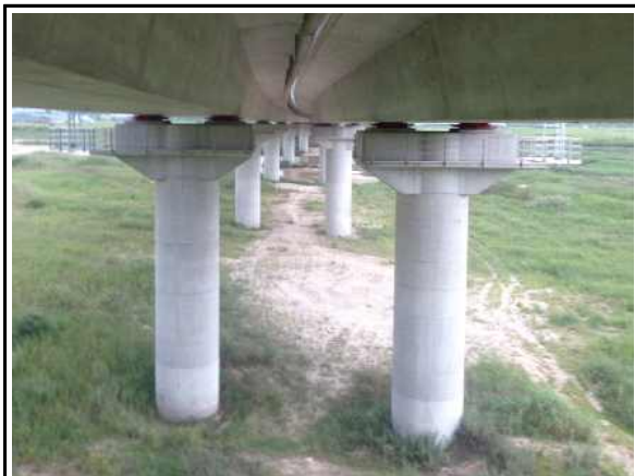
교각 P2 점검로 현황
