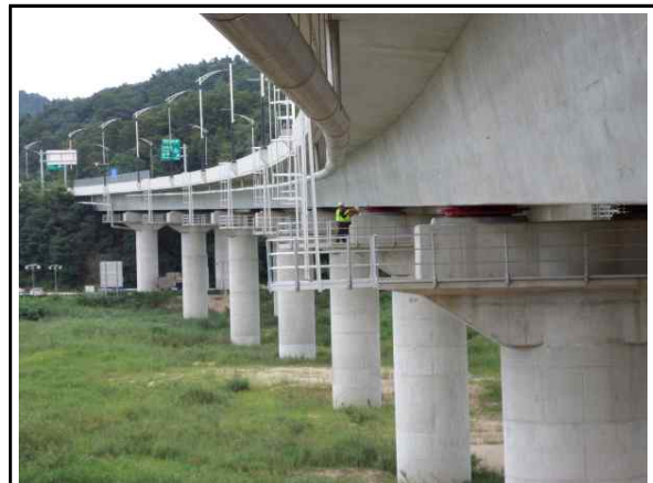
교각 P6 점검로 현황
